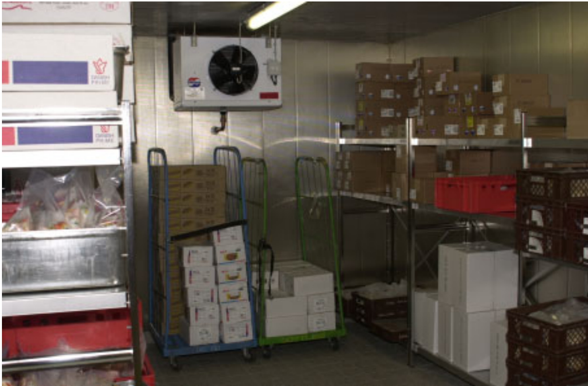
Bild 18: Beispiel: für Installation eines Luftkühlers in einer Kühlhalle
