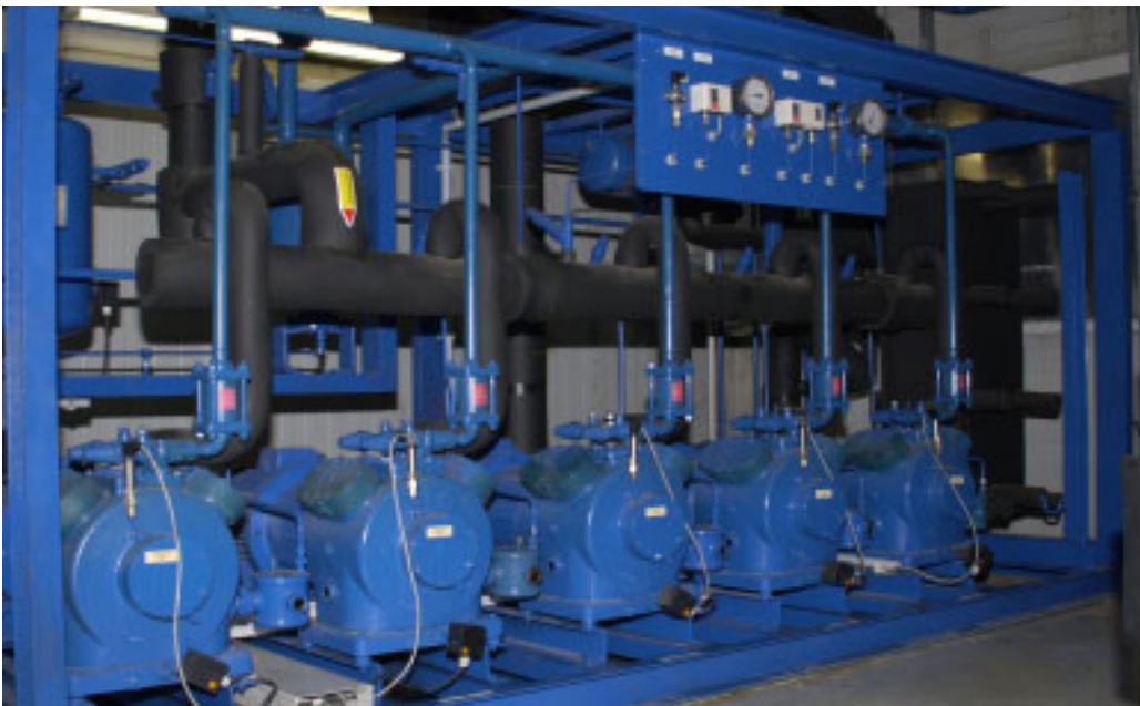
Bild 7: NH 3 /Sole Verbund-Zweikreisanlage
