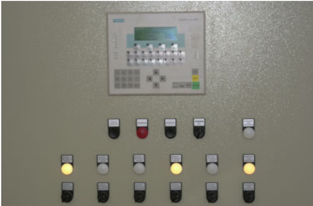
Bild 8: Bediendisplay einer programmierbaren Steuerung SIEMENS C7
