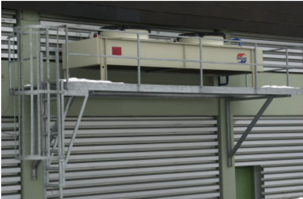
Bild 3: Beispiel: Axialkondensator
