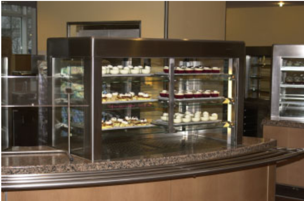
Bild 13: Dessert-Ausgabekühlstelle mit 2800 W, eingebunden an eine Zweikreisanlage
