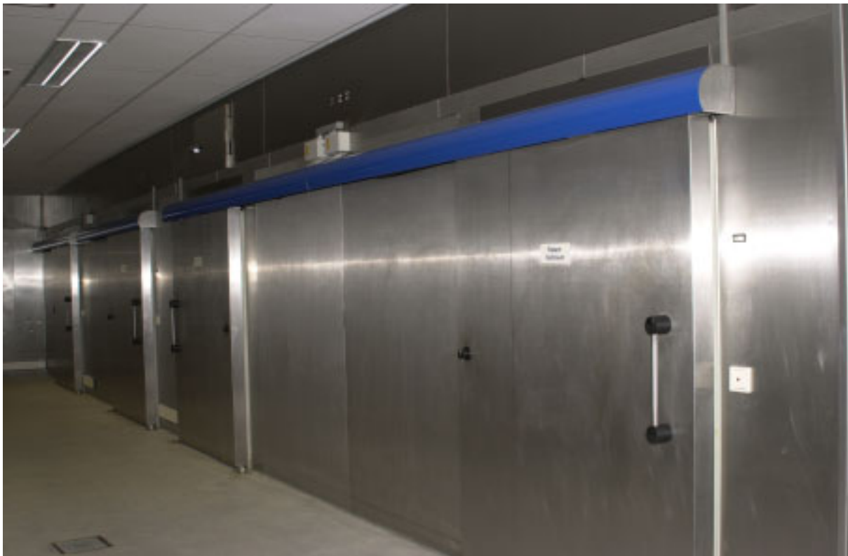
Bild 17: Kühlraumfront, Kühlelemente mit konventionellem Fußbodenaufbau; im oberen Bereich ist die Revisionsluke zu erkennen
