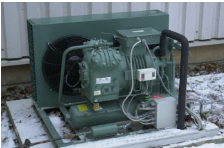
Bild 5: Luftgekühltes Einzelaggregat mit halbhermetischen Kompressoren
